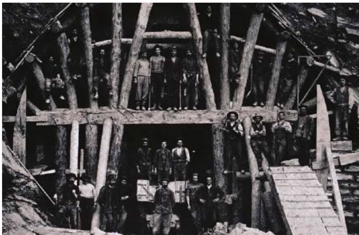
Operai italiani posano sulle imponenti impalcature all'entrata del versante sud della galleria del Lötschberg (da K. Kovári - R. Rechtig, Trafori alpini storici in Svizzera: S. Gottardo, Sempione, Lötschberg , Zurigo 2000).
